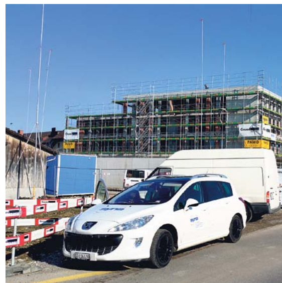
Syna besucht regelmässig Baustellen. Bild: Bojan Trajkov
